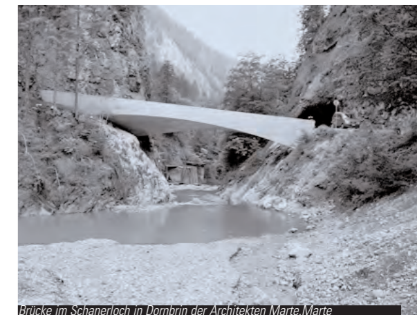
Brücke im Schanerloch in Dornbrin der Architekten Marte.Marte
